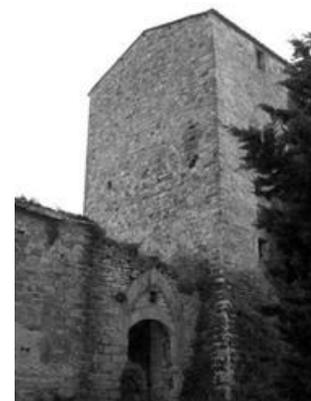
"Altissimo torrione rettangolare in filaretto, tuttavia sbassato come mostrano le tracce di finestre tronche alla sommità: alta base a scarpa e finestre o tracce di finestre ad arco tondo su ciascun lato ed una porta analoga al primo piano del lato ovest, sotto la quale è interrotta la scarpa di base per dar posto all'ingresso originario.
